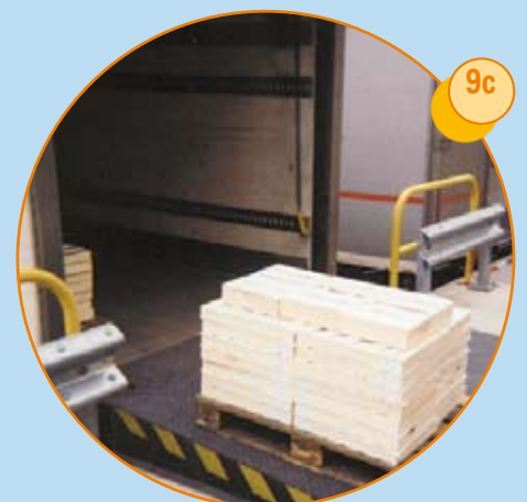
Quai équipé d'un dispositif de mise à niveau
